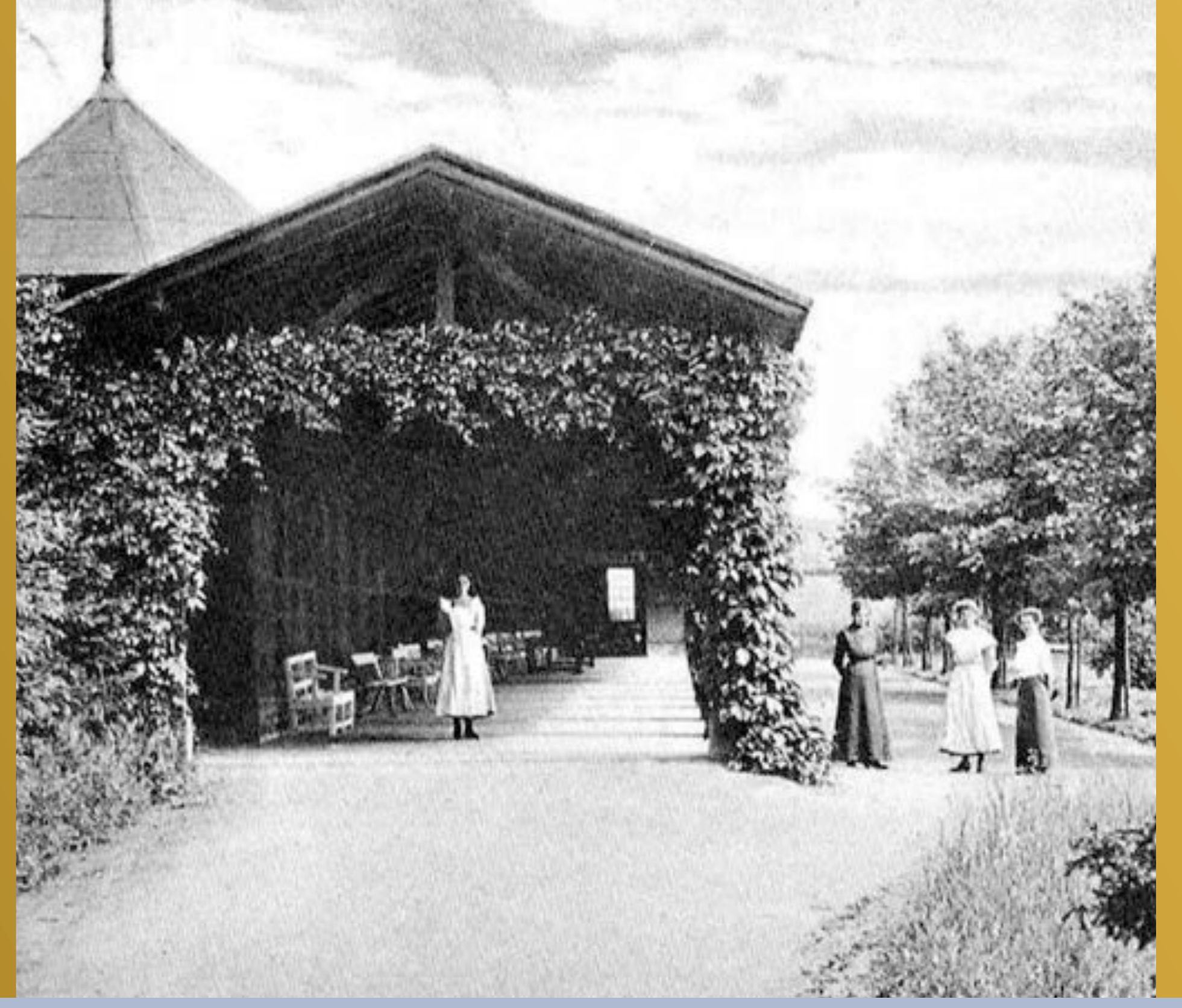
Caspar-Heinrich-Quelle mit Wandelhalle (Standort des heutigen Brunnenbetriebes), Aufnahme von 1914
